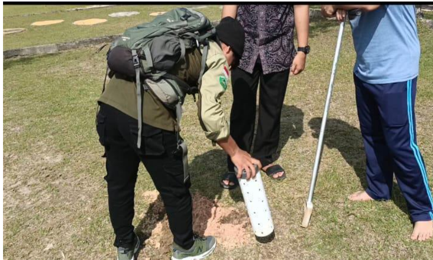
Gambar 2. Praktek Pembuatan Lubang Biopori
